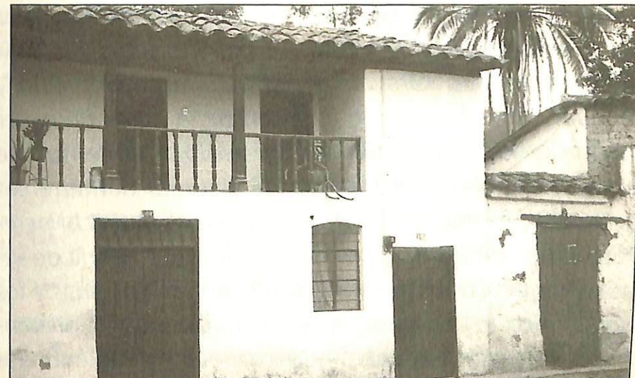
Casa viviente, resago del terremoto. (Av. Teodoro Gómez y C. Domingo Albuja)
